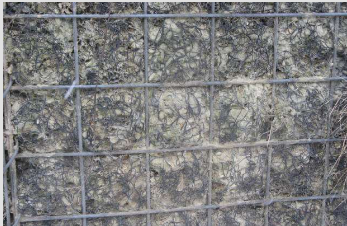
Erosionsschutzmatte beschädigt
